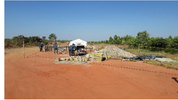
K39+400. OBRA DE ARTE EN CONSTRUCCION
