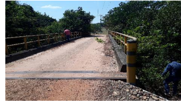
K61+200. PUENTE CAÑO PILON L= 28M.
