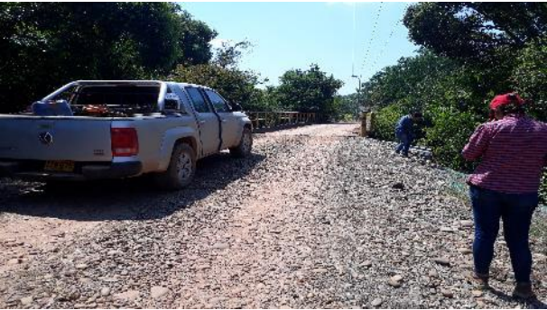
K61+200. PUENTE CAÑO PILON
