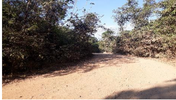
K22+300. PUENTE CAÑO ALMAGRO. VISTA DESDE ADELANTE
