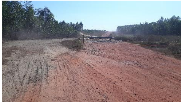
K41+300. ALCANTARILLA 36" RECIEN CONSTRUIDA SIN APROCHES
