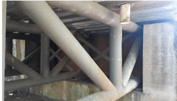
K61+200. TUBERIA DE 8" Y 4" ESTRIBOS EN CONCRETO REFORZADO
