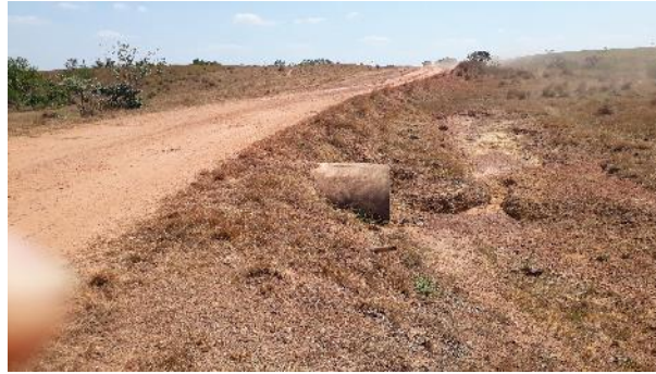
K64+800. TUBERIA DE 36" SIN NINGUN TIPO DE PROTECCION
