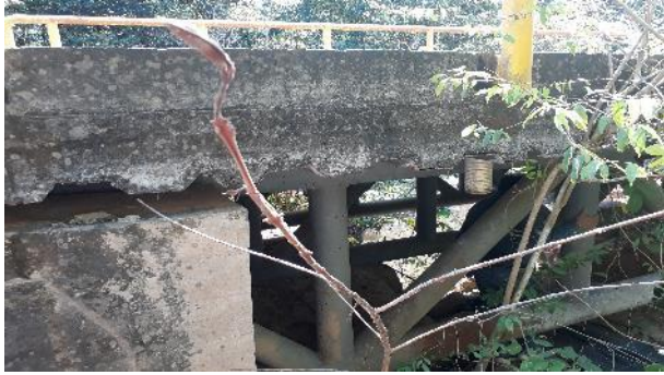
K61+200. PUENTE EL PILON. TUBERIA DE 8" Y 4". PLACA CON LAMINA COLABORANTE
