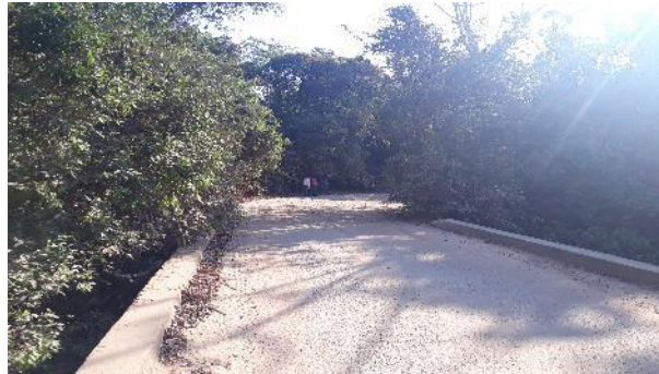
K22+300. VISTA HACIA ATRÁS PUENTE LA PAYARA
