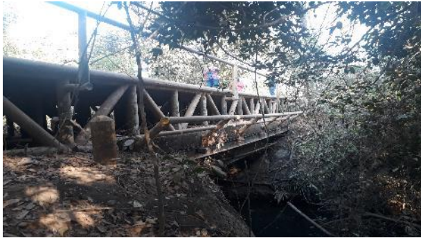
TRES SOLUCIONES DE PASO CONSTRUIDAS EN EL MISMO SITIO UNA SOBRE OTRA CAÑO LA EMMA
