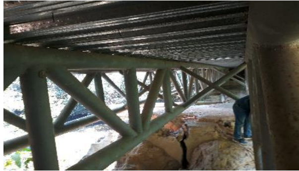
K61+200. PUENTE EL PILON. TUBERIA DE 8" Y 4". PLACA CON LAMINA COLABORANTE
