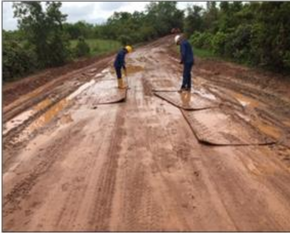
Ilustración 33 Retiro de duradeck en vía de acceso.
