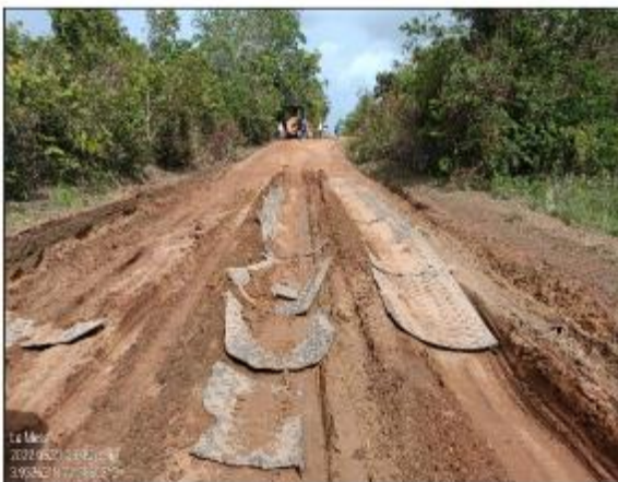
Ilustración 28 Instalación de duradeck en la vía de acceso
