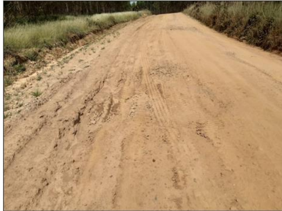
Ilustración 15 Daños existentes en vía de acceso antes del mantenimiento
