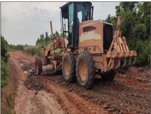
Ilustración 20 Extendido y compactación de material de río
