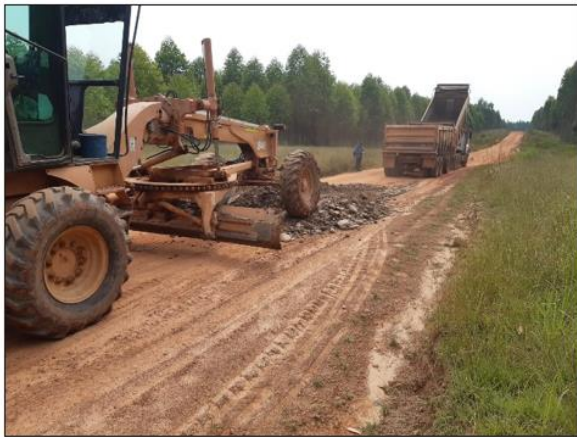
Ilustración 19 Acarreo de crudo de río para mantenimiento de vía de acceso
