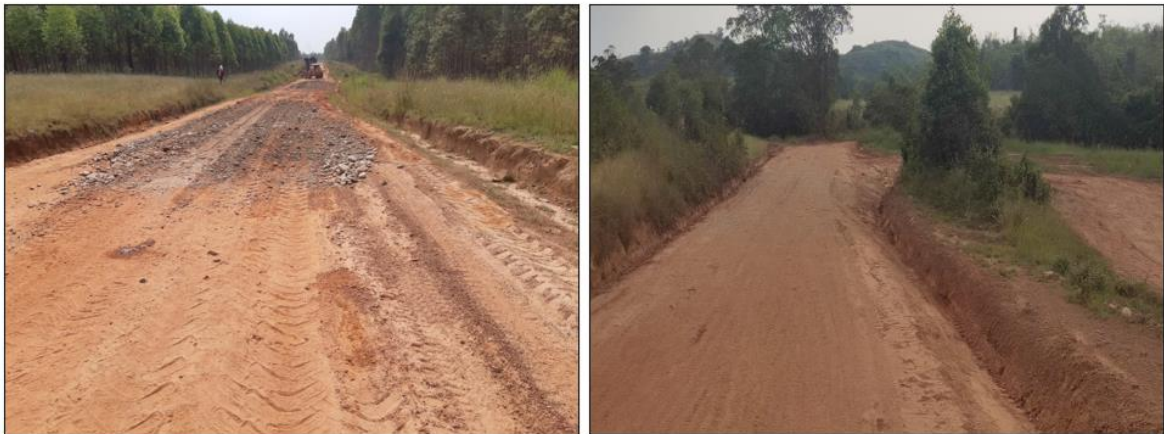
Ilustración 22 Extendido y compactación de material de río
