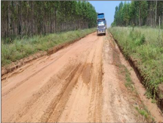
Ilustración 15 Daños existentes en vía de acceso antes del mantenimiento
