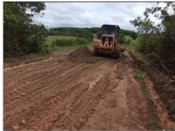
Ilustración 34 Conformación puntos críticos en vía de acceso.
