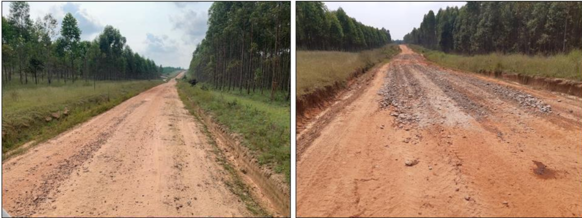
Ilustración 24 Extendido y compactación de material de río
