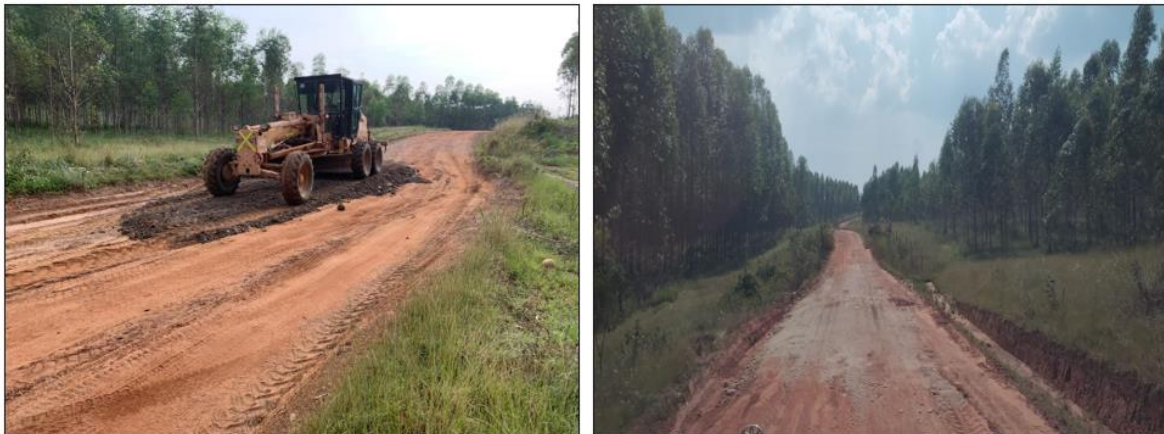
Ilustración 25 Extendido y compactación de material de río
