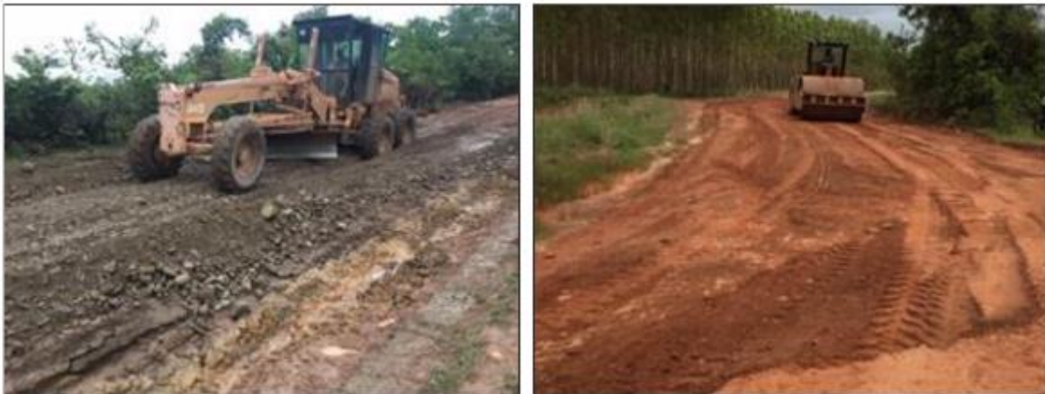
Ilustración 4 Perfilado, conformación y compactación de vía de acceso
