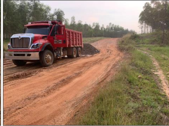
Ilustración 18 Acarreo de crudo de río para mantenimiento de vía de acceso
