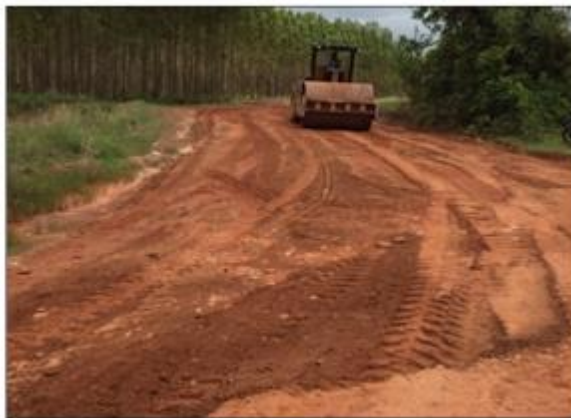
Ilustración 29 Conformación puntos críticos en vía de acceso
