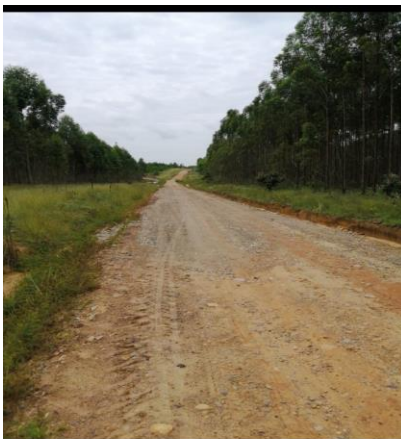
Km40+000 cuneta en la margen derecha y 4 viajes
