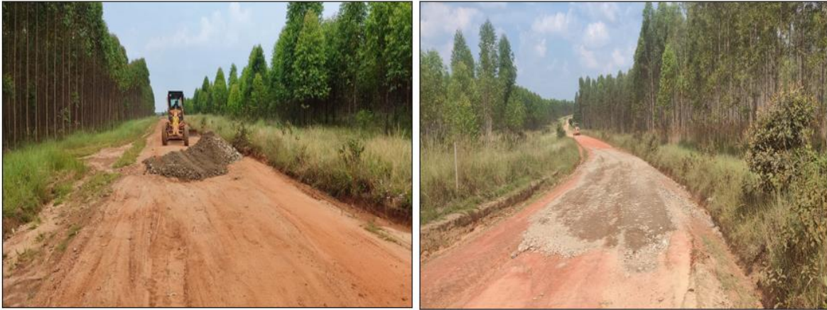
Ilustración 21 Extendido y compactación de material de río
