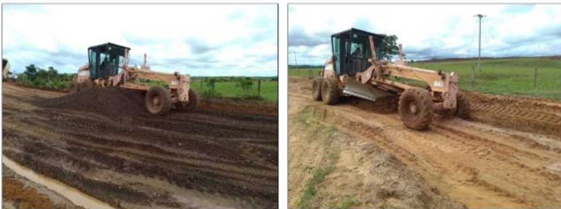
Ilustración 2 Reconformación de vía de acceso
