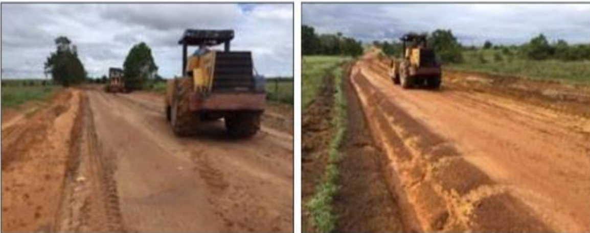
Ilustración 11 Vibrocompactador en vía de acceso
