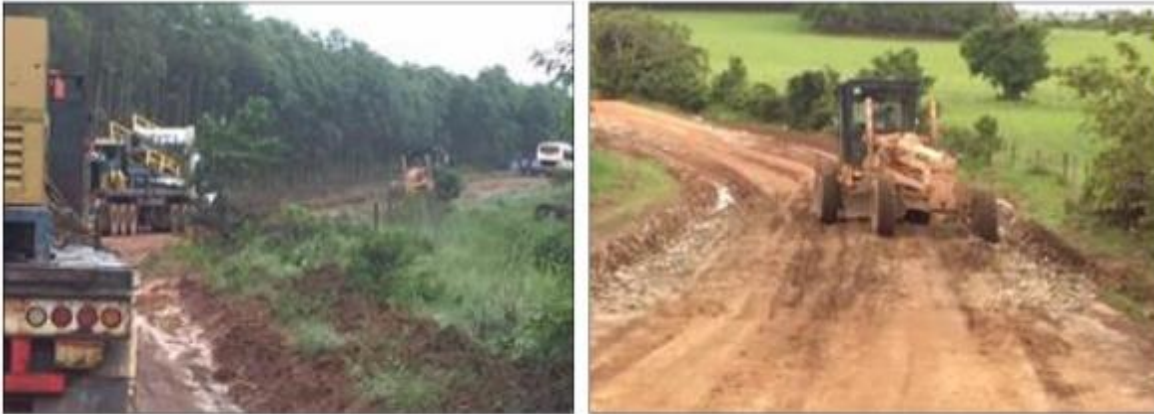
Ilustración 10 Motoniveladora en vía de acceso
