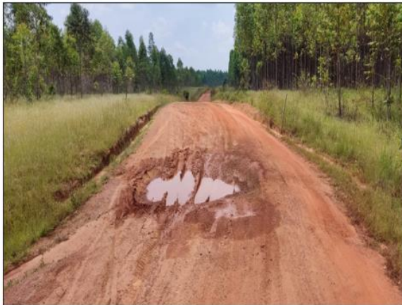
Ilustración 16 Daños existentes en vía de acceso antes del mantenimiento
