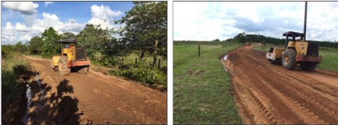
Ilustración 3 Reconformación de vía de acceso
