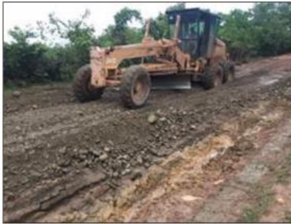
Ilustración 27 Conformación puntos críticos en vía de acceso
