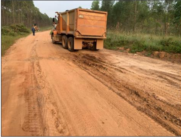
Ilustración 18 Acarreo de crudo de río para mantenimiento de vía de acceso
