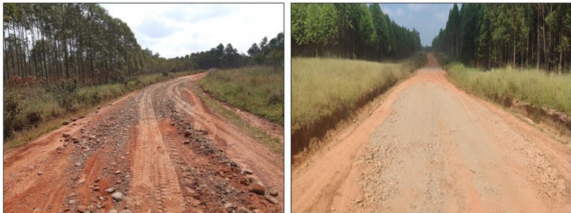
Ilustración 23 Extendido y compactación de material de río
