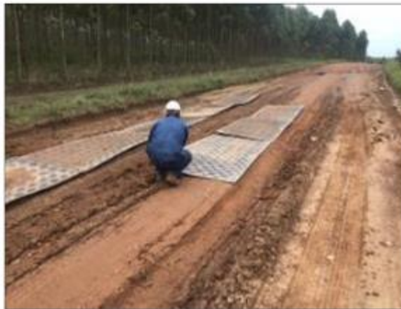
Ilustración 28 Instalación de duradeck en la vía de acceso
