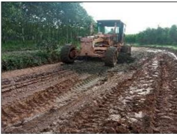
Ilustración 34 Conformación puntos críticos en vía de acceso.
