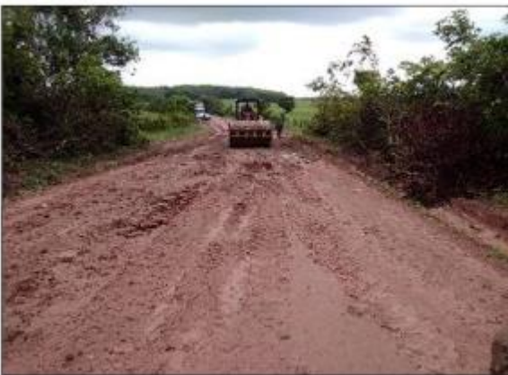
Ilustración 29 Conformación puntos críticos en vía de acceso
