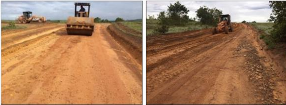
Ilustración 36 Conformación puntos críticos en vía de acceso.
