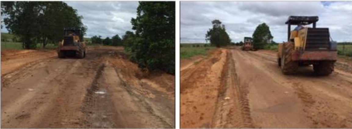
Ilustración 37 Conformación puntos críticos en vía de acceso.
