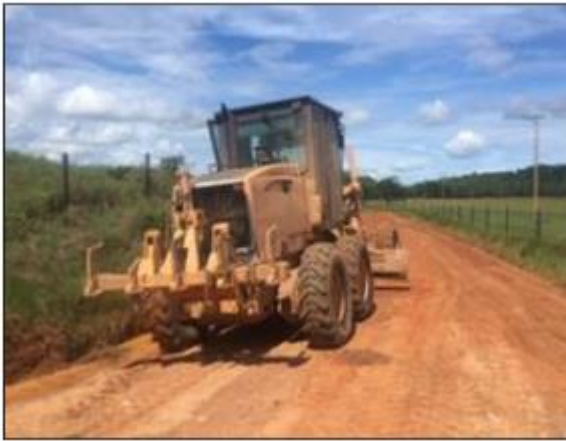
Ilustración 27 Conformación puntos críticos en vía de acceso
