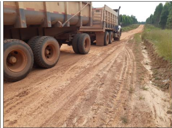
Ilustración 19 Acarreo de crudo de río para mantenimiento de vía de acceso
