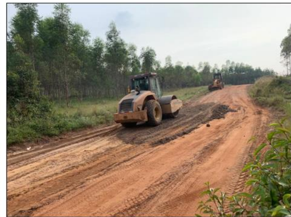
Ilustración 20 Extendido y compactación de material de río
